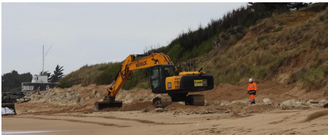
Travaux entre la Cotinière et la plage de Vert bois en mai et juin 2021 © Amicie d'Augustin/LPO
