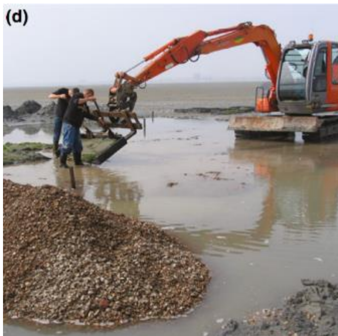
(d) Dépôt des mottes sur le site
