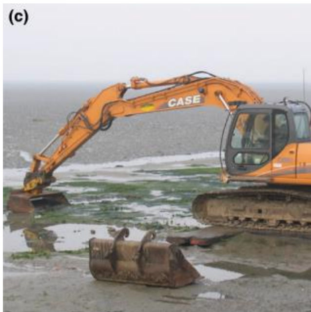
( c ) Prélèvement mécanique des mottes à l'excavateur dans des boxes spécialement conçues
